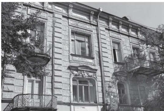
Дом на ул. Мачабели №16
