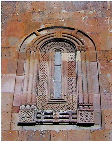
დასავლეთი კედლის მარჯვენა სარკმელი Правое окно на западной стене Right-hand window on the west wall
