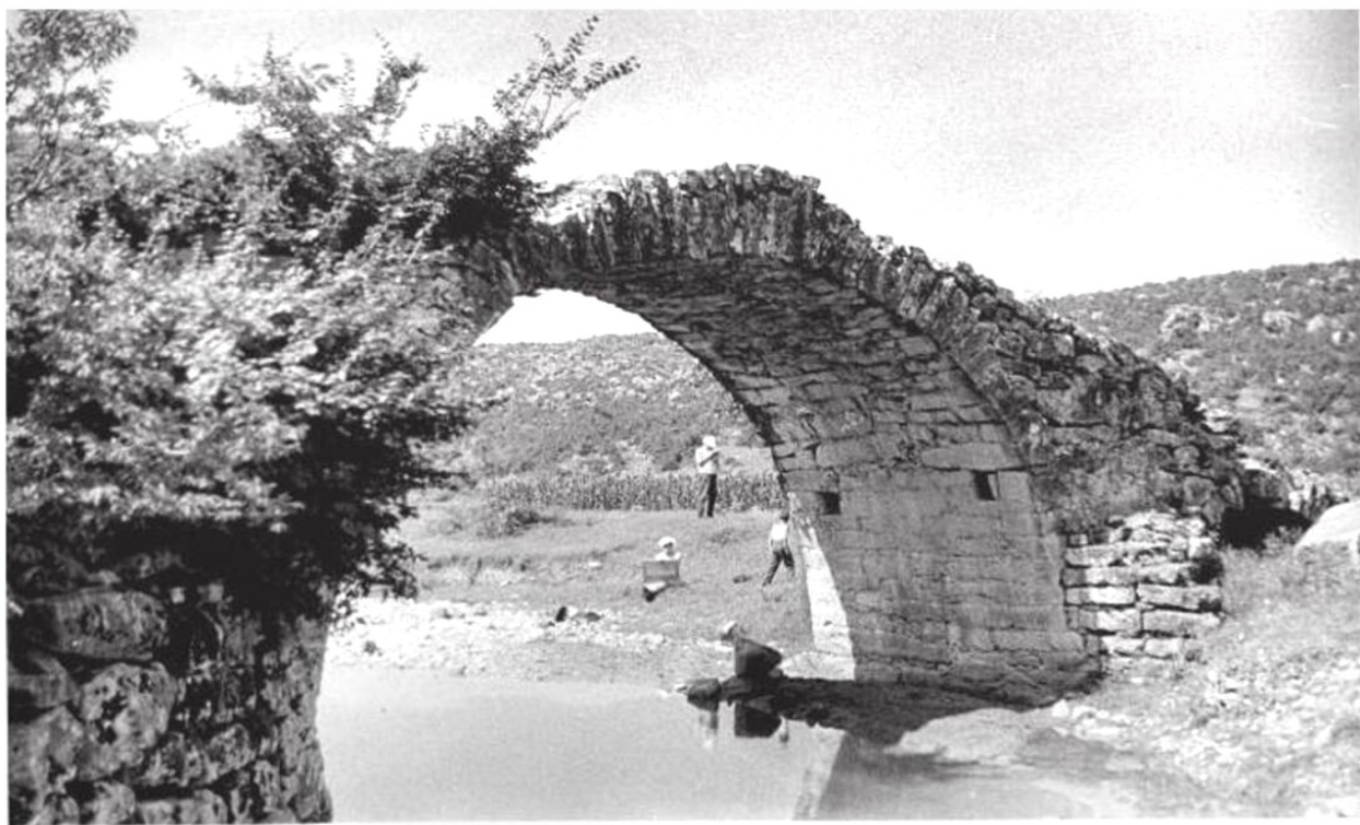
სურ. 7. ჭიშურას ხიდი. საერთო ხედი
