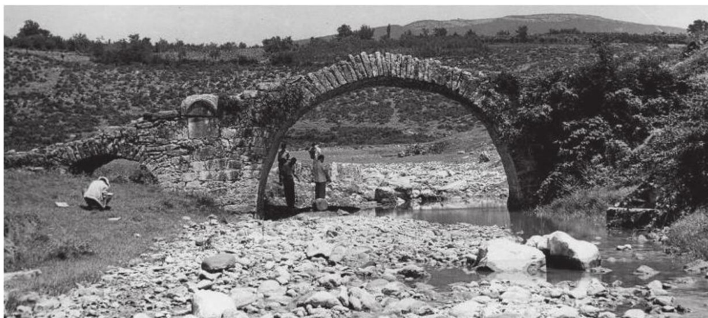
სურ. 6. ჭიშურას ხიდი. საერთო ხედი
