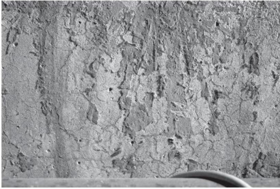
სურ. 1. საღებავის აქერცლილი ფენა ჯვარცმის სცენიდან – რესტავრაციამდე. დერჩის წმ. იოანე ნათლისმცემლის სახ. ეკლესია, XVII ს-ის მოხატულობიდან
