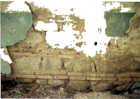
თბილისი. პასტერის ქუჩა 4. ძველი საცხოვრებელი სახლის კედრატული აგურისა და ნატეხი ქვის მონაცემლობითი კედლის ნიშა, ნაძვისა და კირის დუღაბზე. 2011 House at 4 Pasteur Street, Tbilisi
