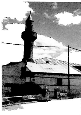
ფოტო 1. ჯამეს საერთო ხედი
