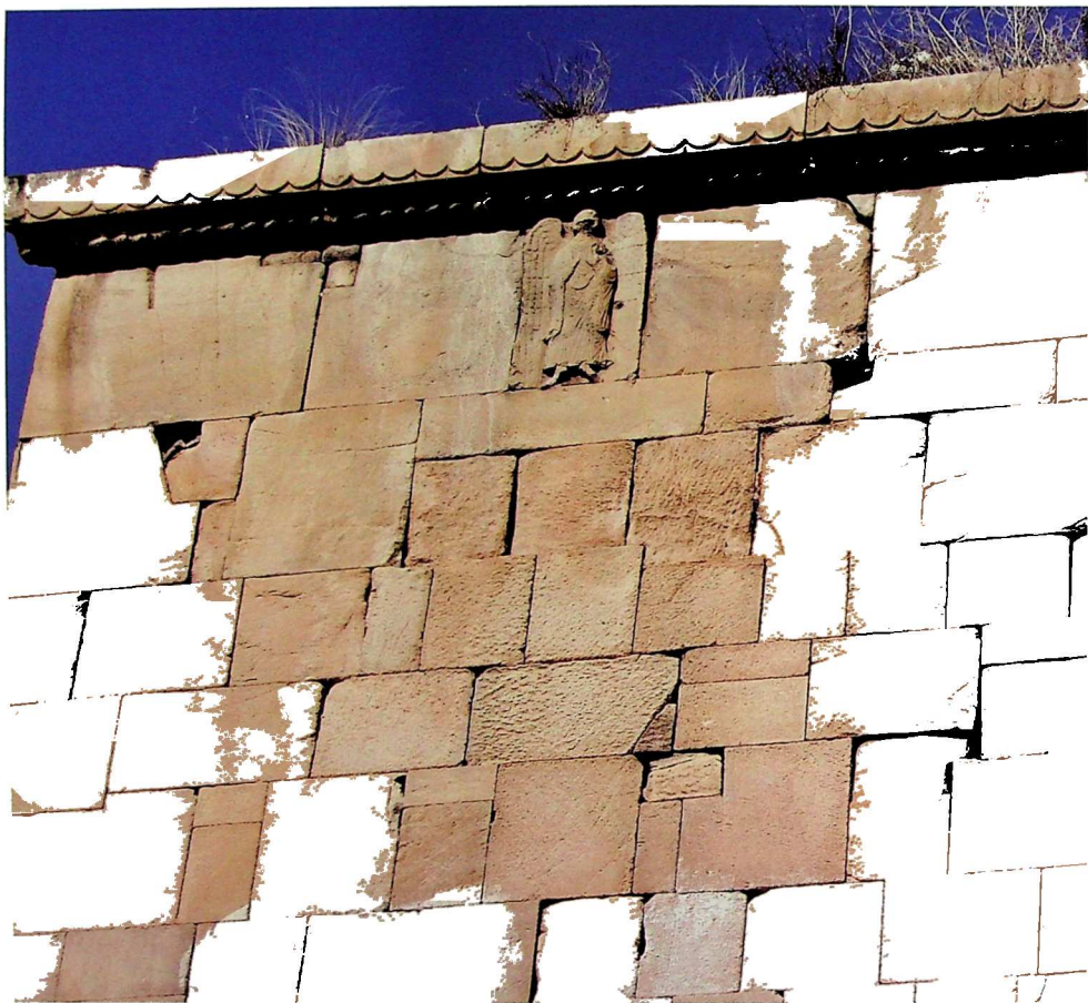
სურ. 119. ოშკის ციხარი. სარაშის კონსოლების ამოხსნეული და ამოუკლებელი ფოსიები სამხრეთ ფასადზე
