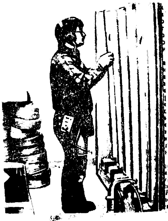
ნახ. 19. მონტორი აწარმოებს სატელეფონო განმანაწილებლის მონტაჟს მანქანიდან მიღებული ინსტრუქციების მიხედვით
